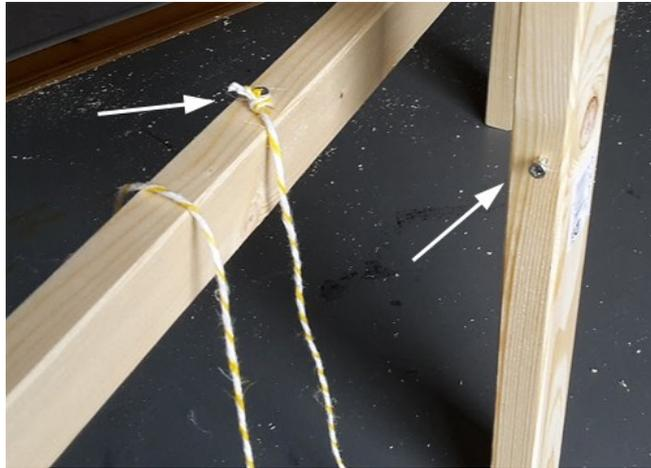
Abschließend wird noch der Querbalken (auf dem die Leinwand aufliegt) erstellt und an die Vorderseite geschraubt:
